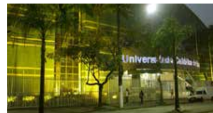
Tradicionalmente, fachadas dos campi são iluminadas de amarelo em setembro
