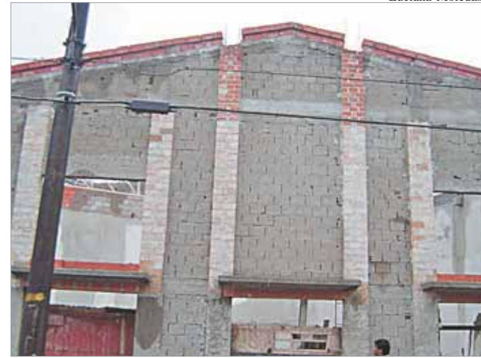
Vitrais, pisos e portas ainda por instalar
