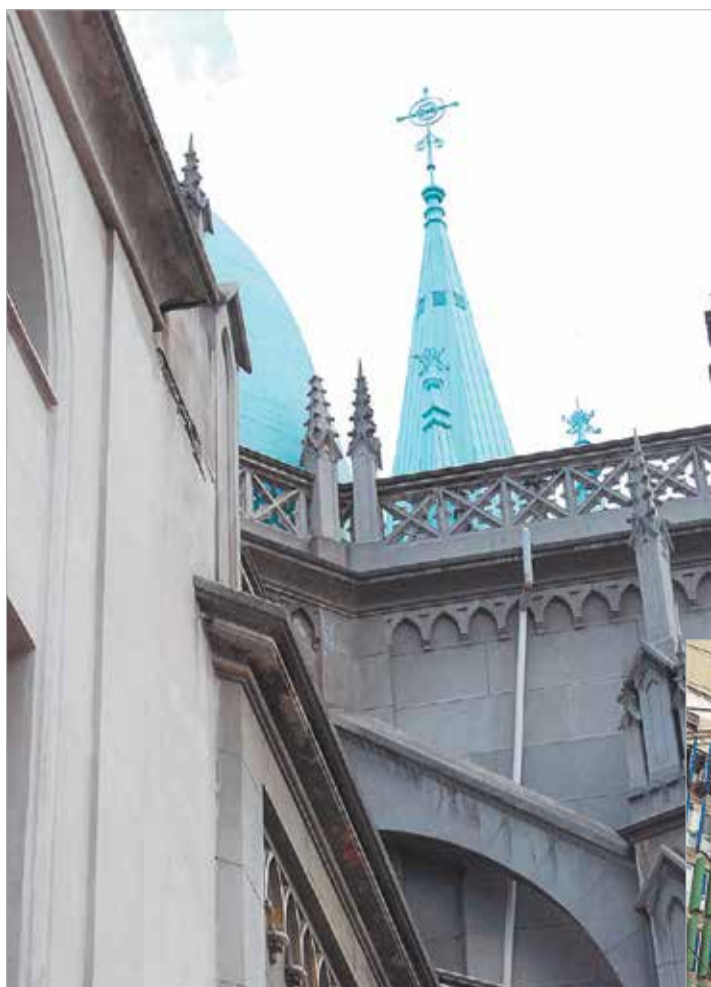
Reforma do telhado e da torre está concluída
