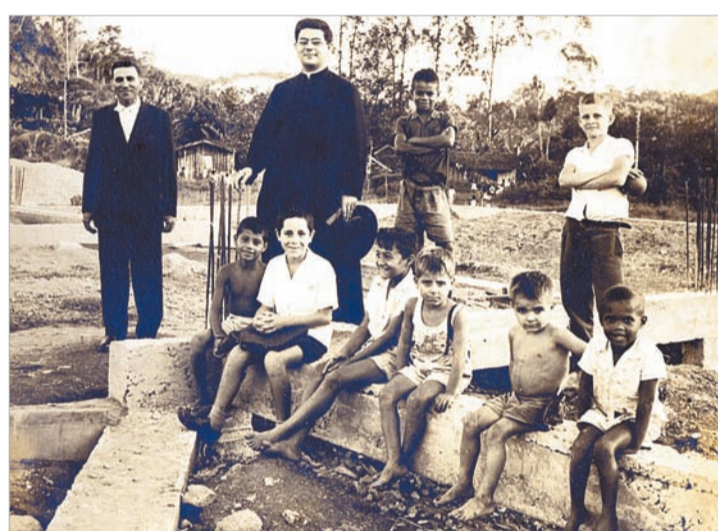
Pe. Crescenti, como encarregado da construção da Igreja S. João Batista, no Nova Cintra, em Santos, com Sr. Manoel Gonçalves, presidente da comissão de festejos, em meados de 1961, bem no início das obras
