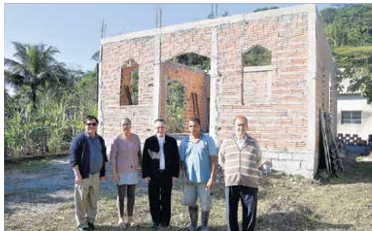
Capela Santa Edwiges (Sítio São João) em construção
