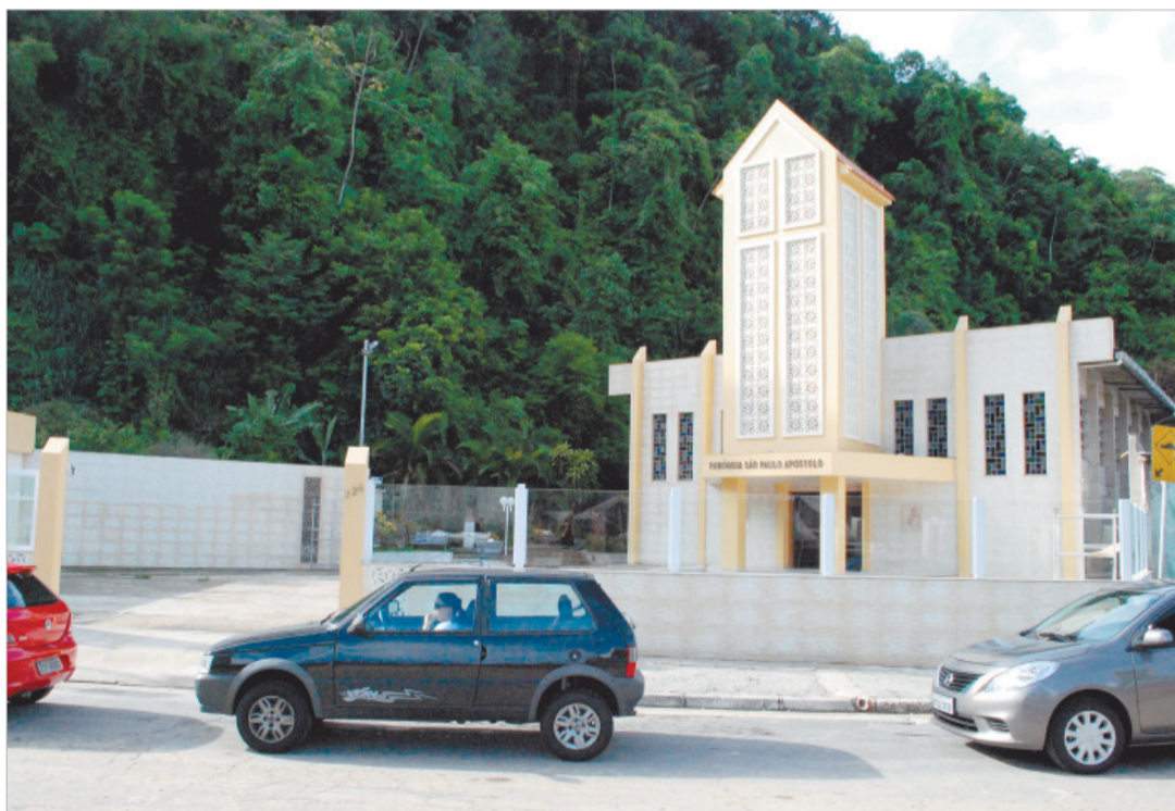
Igreja S. Paulo Apóstolo: muro com painéis de vidro e nova fachada agora são destaque
