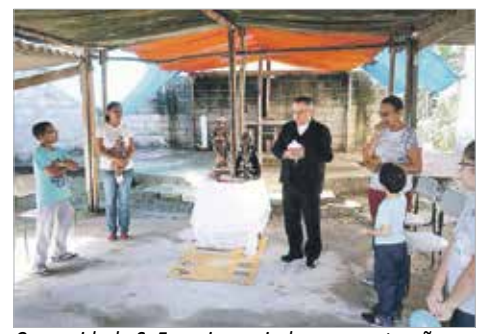
Comunidade S. Francisco, ainda em construção
