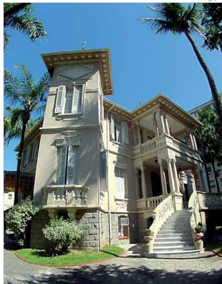
A sede da SVSL é uma construção histórica dos anos 20 do século passado...
