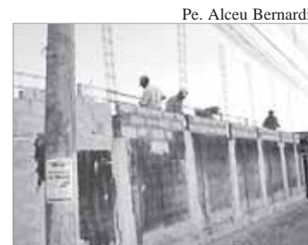
Construção de novas capelas é sinal do aumento da comunidade católica na Região
