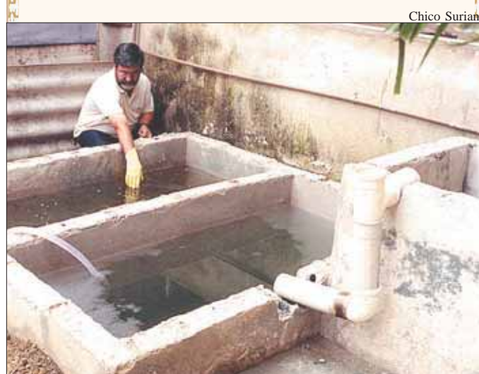
Diácono José Guerra inspeciona construção do reservatório de água de chuva
